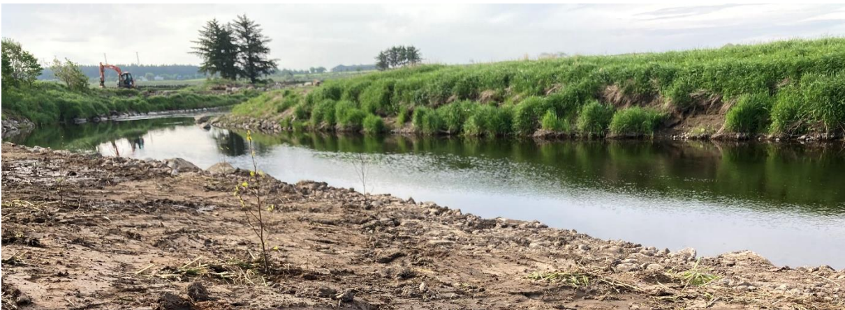
Figur 8-3. Utplanting av busker og trær er anbefalte tiltak i kantsonen. Her fra Håevla, hvor elvekantene har blitt erosjonssikret. Foto: Karin Hansen Nærland.
