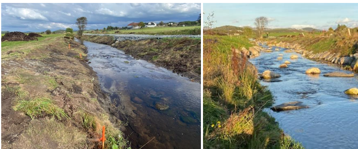
Figur 3-7. Eksempel på aktuell tiltaksutføring i form av tilbaketrukket erosjonssikring av bekkkanter. Bildene er fra Kvernbekken på Klepp (Figgjovassdraget), før og etter harving av bekkbunn og steinsetting av denne. Foto: Knut Ståle Eriksen.
