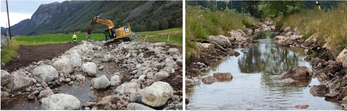
Figur 3-8. Eksempel på aktuell tiltaksutforming i form av ru steinsetting. Til venstre er strykparti i Frøylandsbekken (Dirdalsvassdraget), til høyre er et roligere parti i Kvernbecken på Klepp (Figgjovassdraget). Foto t.h.: Knut Ståle Eriksen.
